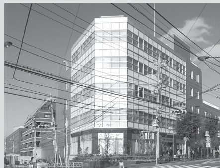
平成22年4月に完成した新社屋は、鉄筋5階建。
