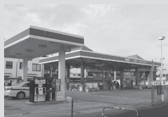
足立区「ツ家」にある 足立オートガススタンド
